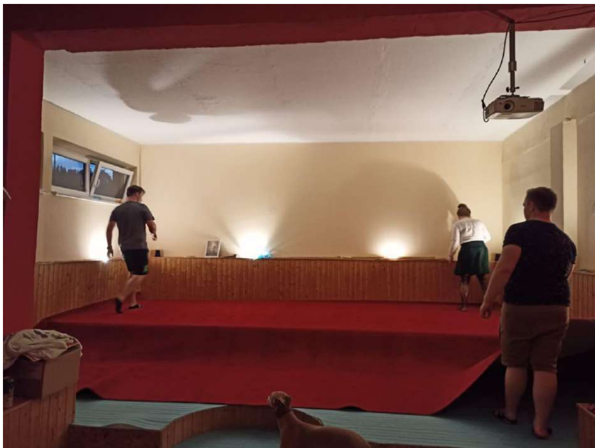
Obrázek 1: výměna koberce v hlavních prostorách
