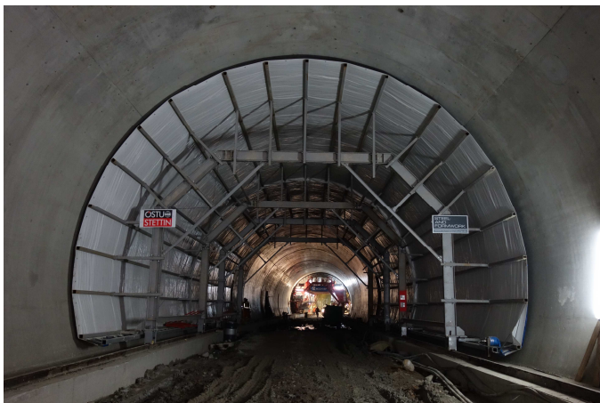
Obr.8 Ošetřovací vůz využitý pro nevyztužené definitivní ostění tunelu Povážský Chlmec
