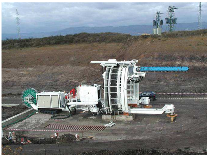
Obr.6 Vrubovací stroj Perforex před zahájením ražby tunelu Březno
