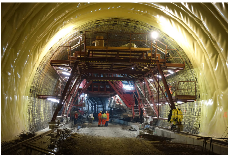
Obr.7 Tradiční postup při výstavbě konvenčně ražených tunelů – instalace fóliové izolace a armatury pro definitivní ostění
