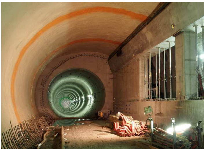
Obr.9 Stříkaná hydroizolace ve stanici metra Nádraží Veveslavín
