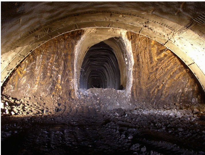
Obr.1 Výstavba tunelu Slivenec (SOKP 514) pomocí NRTM
