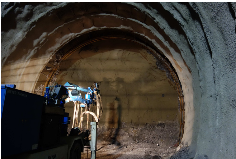
Obr.5 Ražba tunelu Višňové pomocí metody ADECO-RS
