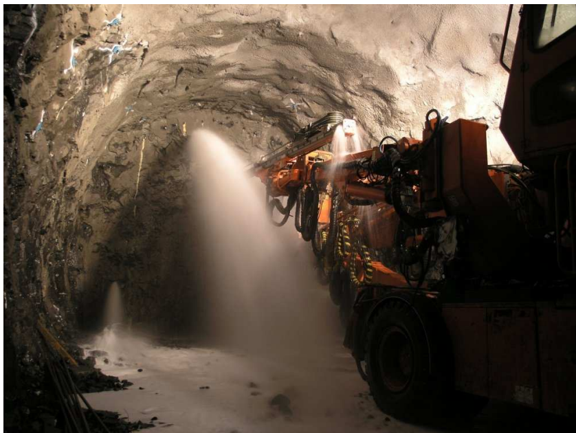
Obr.4 Tlaková voda v tunelu Ólafsfjörður realizovaném NTM
