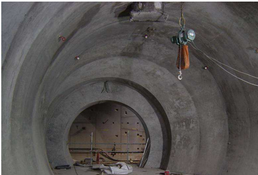
Obr.3 Ostění ze stříkaného betonu zhotovené metodou LaserShell
