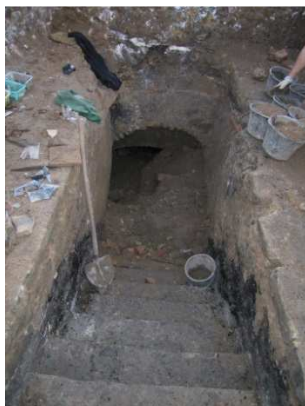
Obr. č. 5: Odkrytý vstup do zapomenutých sklepů. Foto archiv Hlaváček-architekti:
