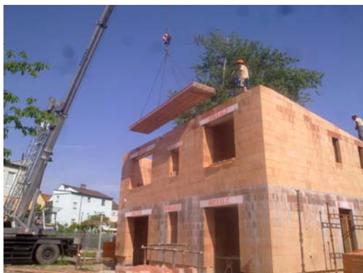
Obr. 4 Realizace střešní konstrukce
