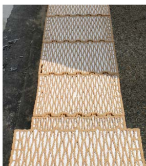
Obr. 3 Zakládání zdiva
