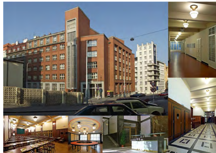
Obr.20 Domu zemědělské osvěty z roku 1927 od architekta Gočára ve Slezské ulici, Praha 2, kompletní rekonstrukce a obnova do původní historické podoby včetně interiéru a nábytku, 2012
