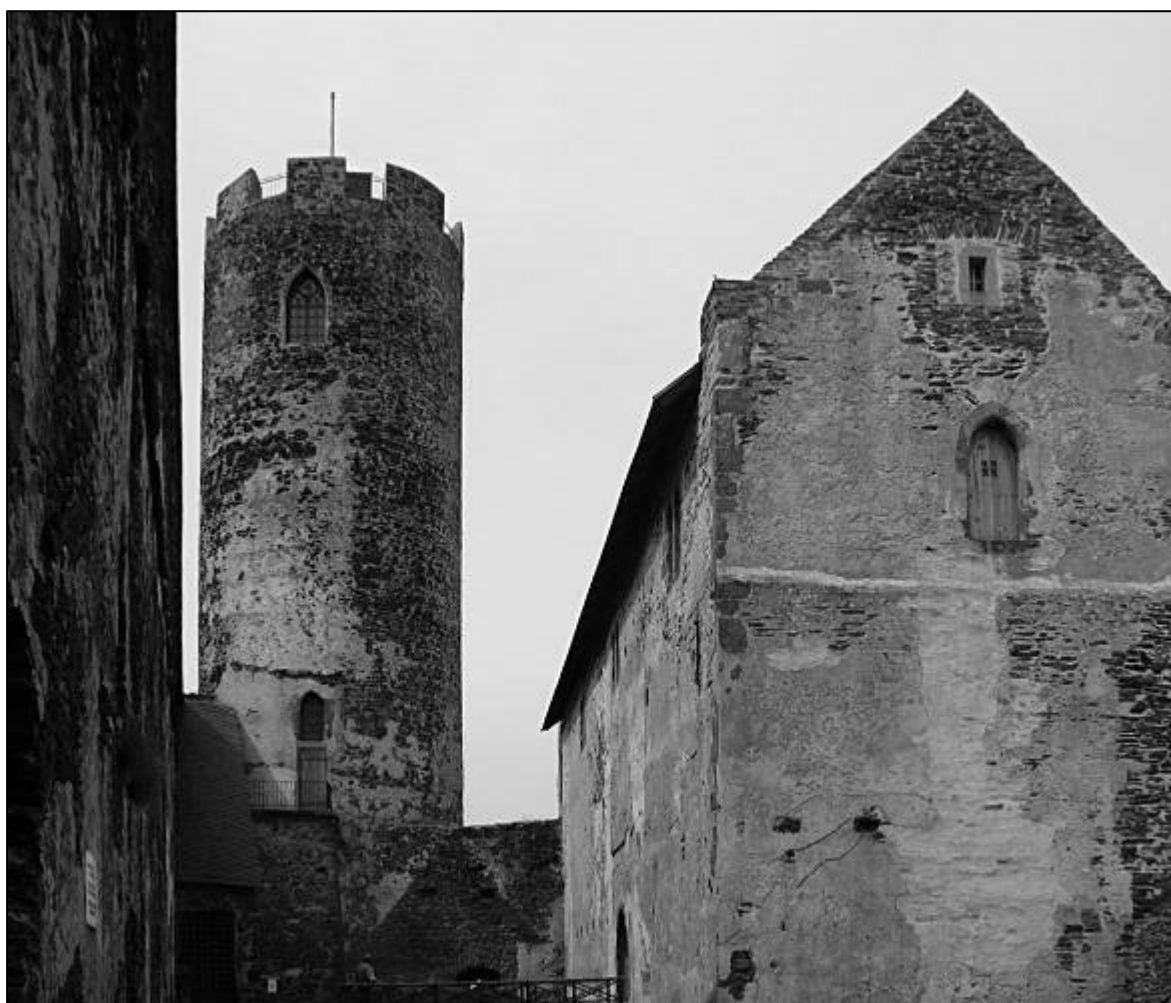
Obr. 16. Konzervace dvorních průčelí purkrabského paláce hradu Bezděz (projekt 1992, realizace 1993)
