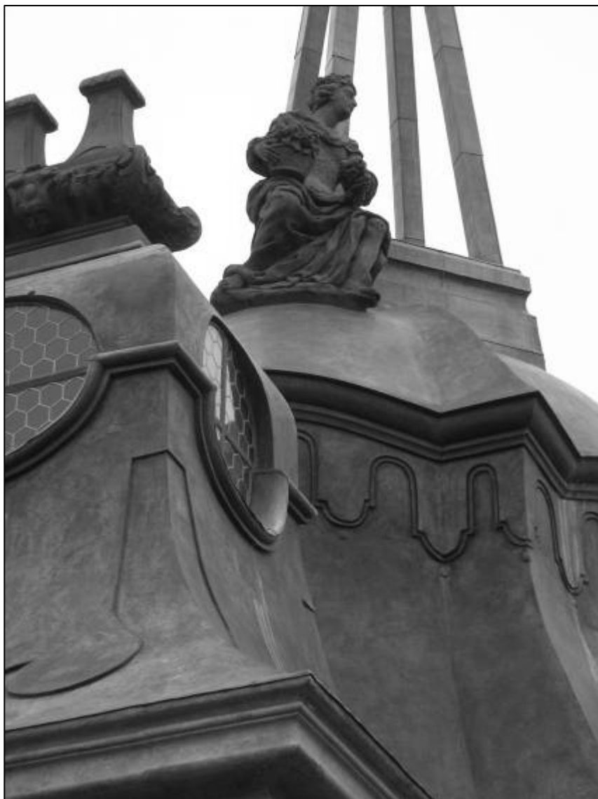
Obr. 10. Rehabilitace gloriety zámku v Ploskovicích (projekt 2003, realizace 2006)
