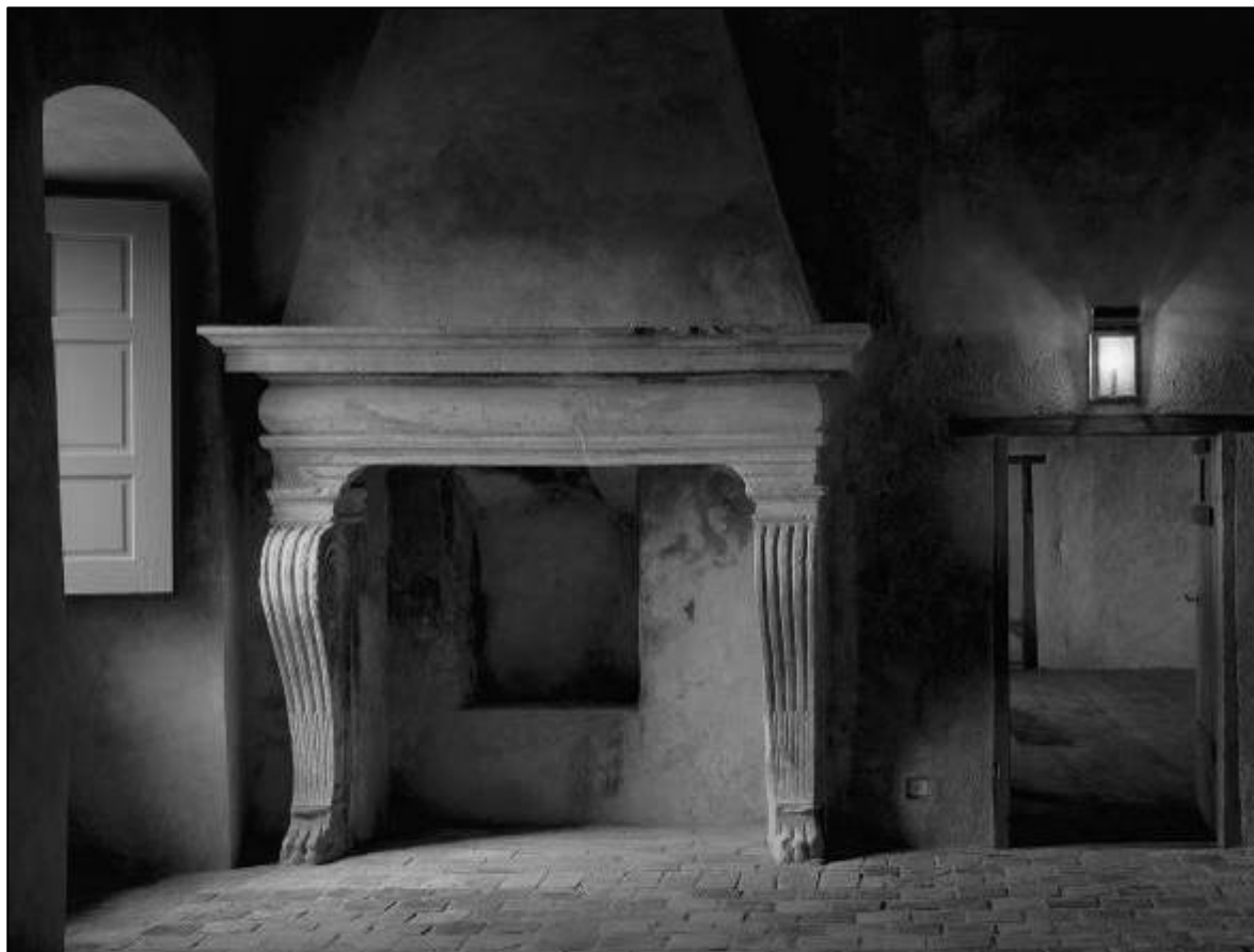
Obr. 6. Rehabilitace interiérů hradu Grabštejn s interiérovou instalací (projekt 2001, realizace 2002)
