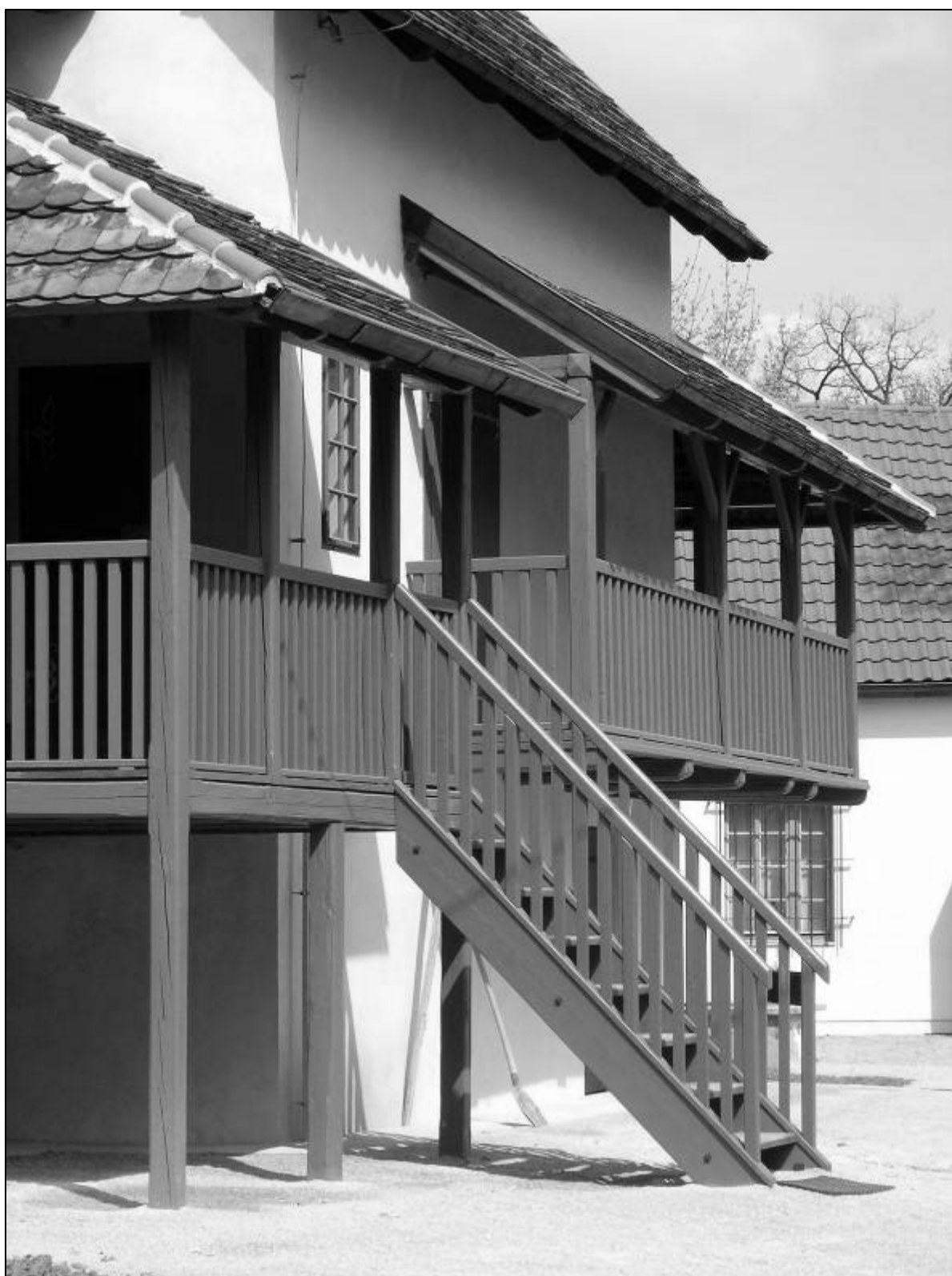
Obr. 7. Rehabilitace atelieru Zdenky Braunerové v Roztokách u Prahy (projekt 2002, realizace 2003)
