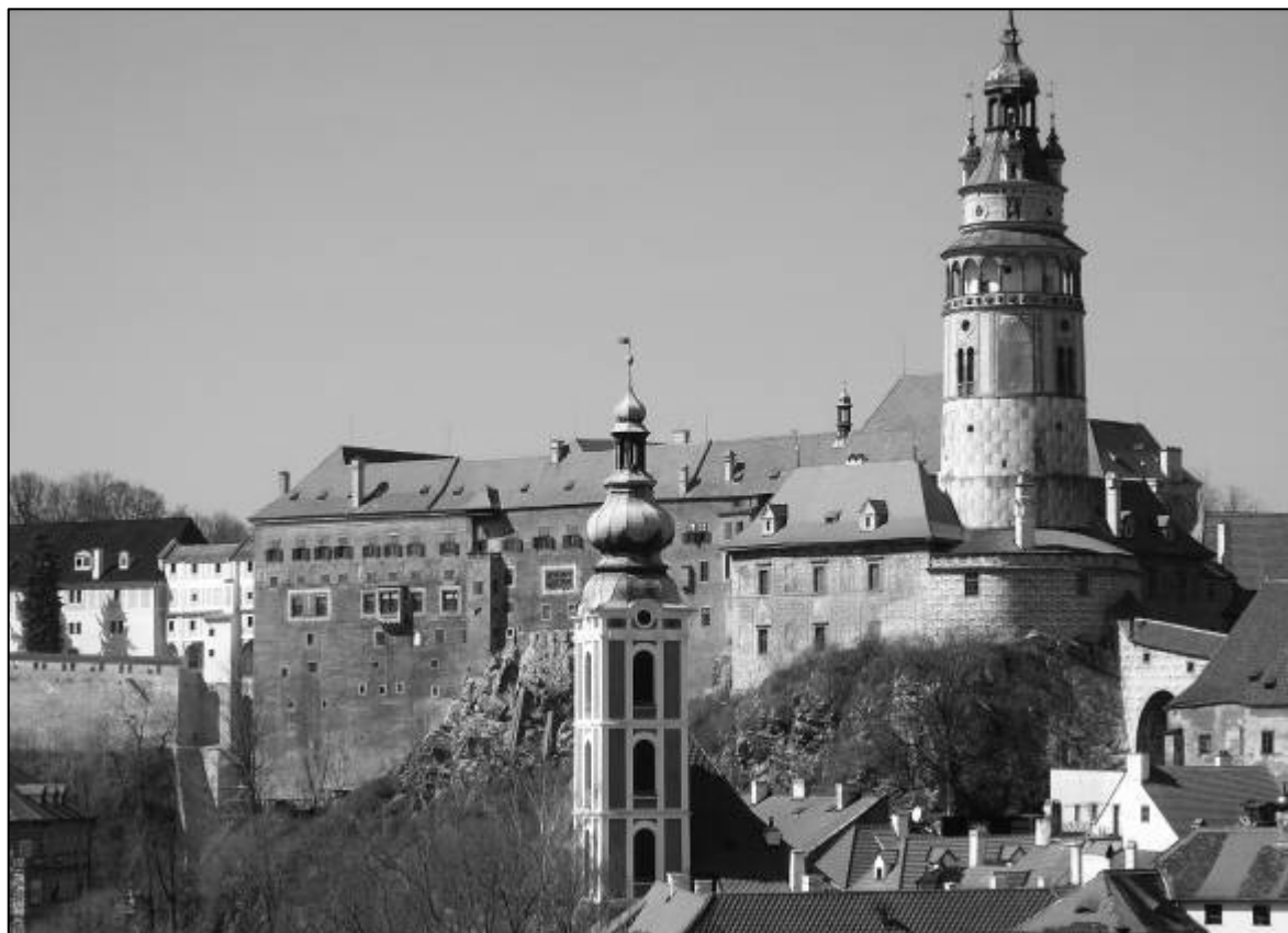
Obr. 4. Obnova věže Hrádku v Českém Krumlově (projekt 1992, realizace 1993), restaurování jižního průčelí Horního hradu zámku v Českém Krumlově (projekt 2002, realizace 2004)
