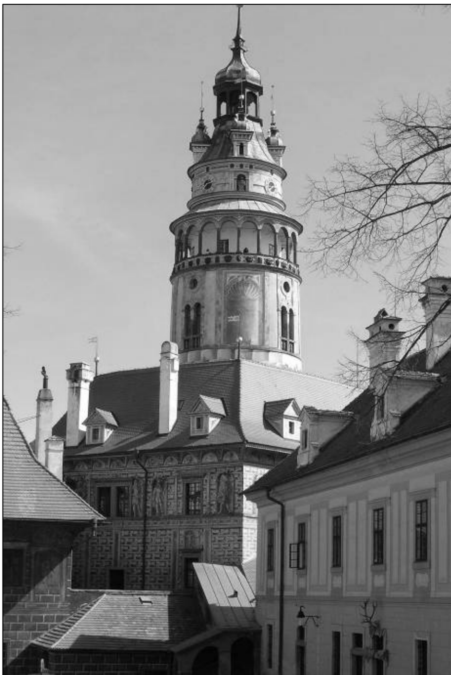
Obr. 12. Obnova věže Hrádku v Českém Krumlově (projekt 1992, realizace 1993)
