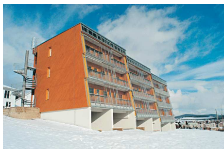
Obr. 3 Nizkoenergetický nízkonákladový bytový dům Sušice
