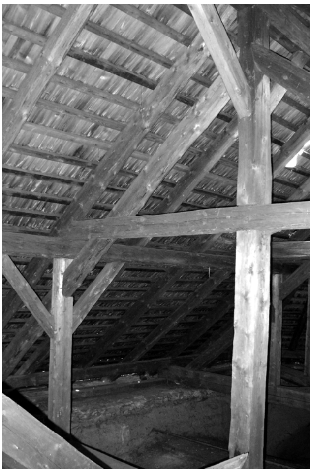
9. – 11. Záběry z krovu nad kostelem Nanebevzetí Panny Marie v Horním Maršově v Krkonoších, 1868.
