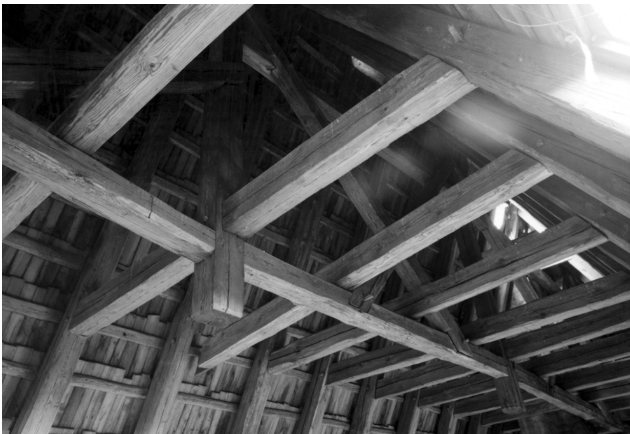
5. Krov nad jižním křídlem zámku v Kuřívodech u Mimoně, polovina 16. století.
