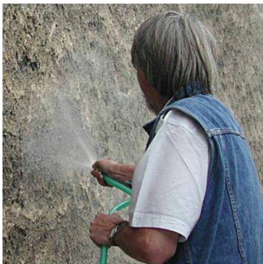
Obr. 29 Zpevňování omítek pomocí opakované aplikace vápenné vody postřikem (dostupné online: http://docplayer.cz/16244222-Prakticke-postupy-obnovy-a-konzervace-stavebniho-dila-minulosti.html )
