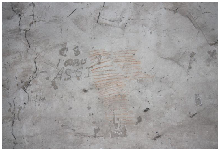
Obr. 8 a) Gotický donjon hradu v Bečově nad Teplou se zachovanými úpravami povrchů v exteriéru i interiéru; b) detail provedení omítky v interiéru donjonu, s čitelnými nerovnostmi a patrnými tahy zedníka. (Foto K. Kroftová)
