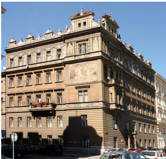
Obr. 3 Příklad městského činžovního domu z počátku 20. století s dochovanou dekorativní úpravou průčelí a výplněmi otvorů (Praha – Smíchov, foto K. Kroftová)
