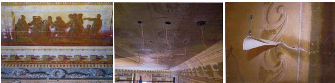
Obr. 46 Státní zámek Uherčice: a) Iluzivní malba b) stabilizace husté sítě prasklin tampóny z nanotextilie PVA, c) detail vyplnění trhlin tampóny z nanotextilie PVA
