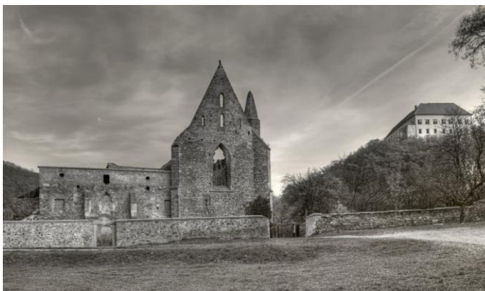
Obr. 42 Bývalý klášter Rosa Coeli v Dolních Kounicích, kde byla provedena první reálná aplikace nanosuspenze hydroxidu vápenatého v ethanolu (CaLoSi®25) v ČR Dostupné online: http://www.turistika.cz/fotogalerie/56000/cr-dolni-kounice-rosa-coeli-ruze-nebeska ><img
