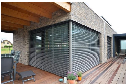
Obr. 10 Využití venkovních stínících prvků – žaluzií [27]
