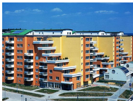
Obr. 7 Stínění balkónovou deskou [35]
