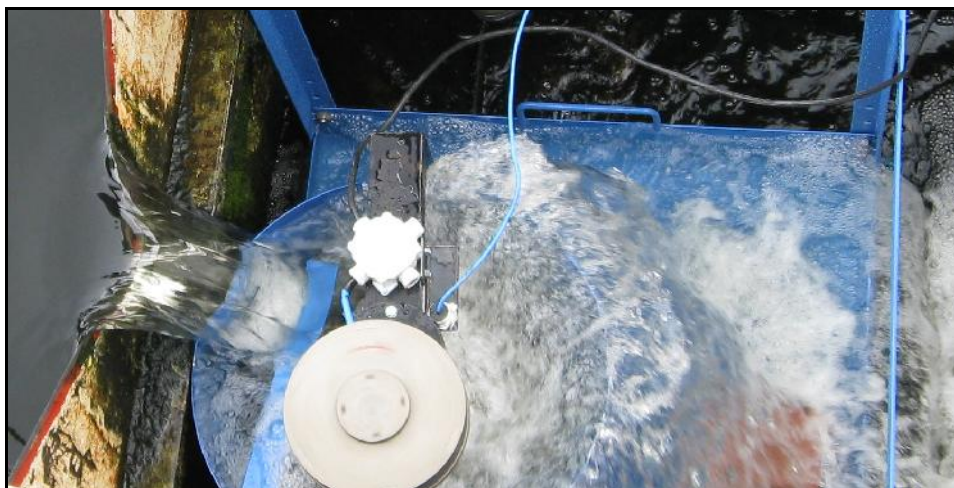
Obr. č. 13 Miniturbína instalovaná na výtoku z čistírny odpadních vod
