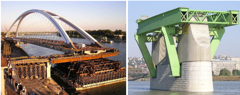
Obr. 8 Most po přesunu na soulodí, vpravo definitivní pilíř
