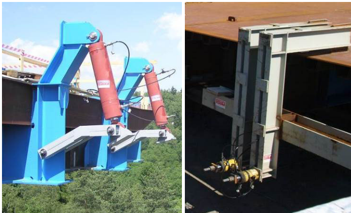
Obr. 17 Klapka pro eliminaci průhybu a tlačný příčník
