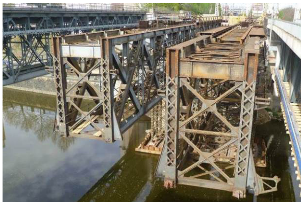
Obr. 12 Odstrojená původní nosná konstrukce při výsunu
