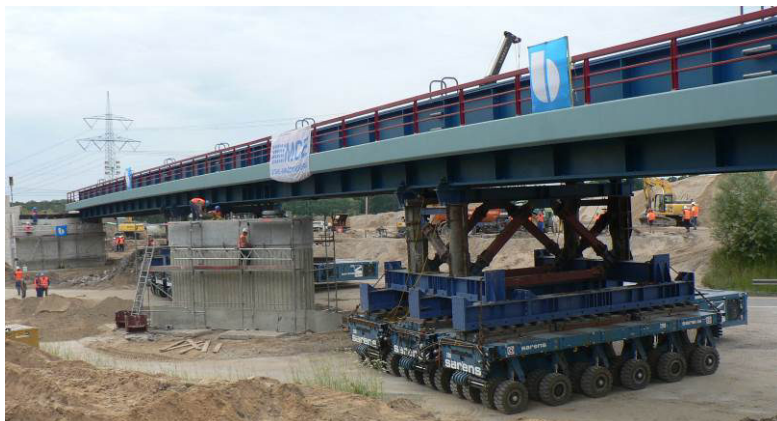
Obr. 18 Pohled na přemísťovanou NK na hydraulických podvozcích
