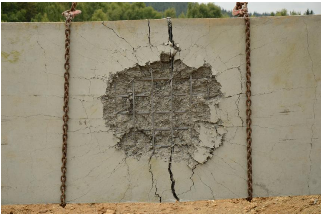
Obr. 14 – Vzorek č. 4 poškozený výbuchem – dolní povrch
