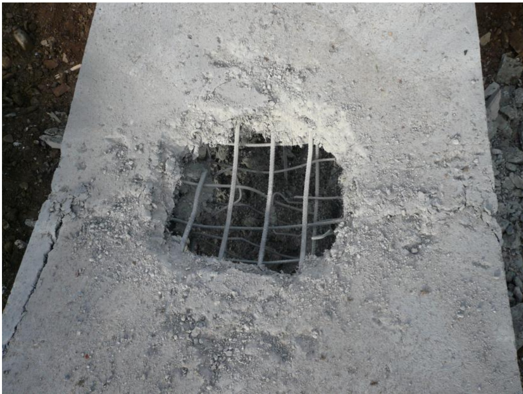
Obr. 9 – Vzorek č. 2 poškozený výbuchem – horní povrch
