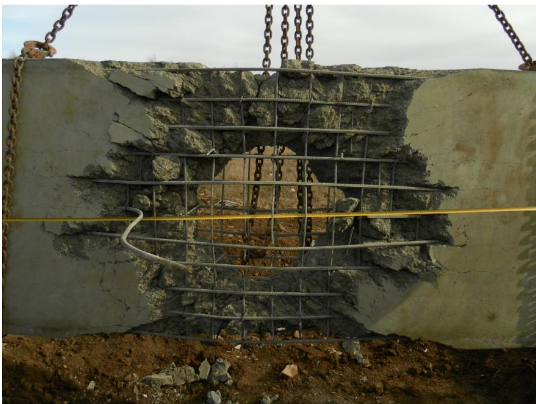
Obr. 8 – Vzorek č. 1 poškozený výbuchem – dolní povrch
