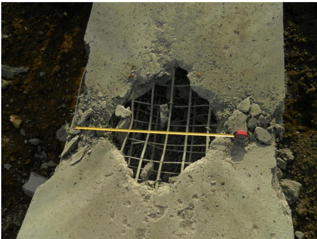
Obr. 7 – Vzorek č. 1 poškozený výbuchem – horní povrch
