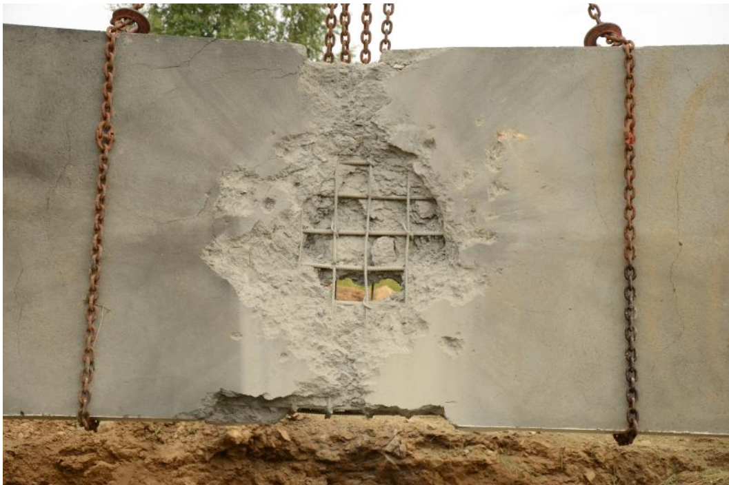
Obr. 11 – Vzorek č. 3 poškozený výbuchem – horní povrch
