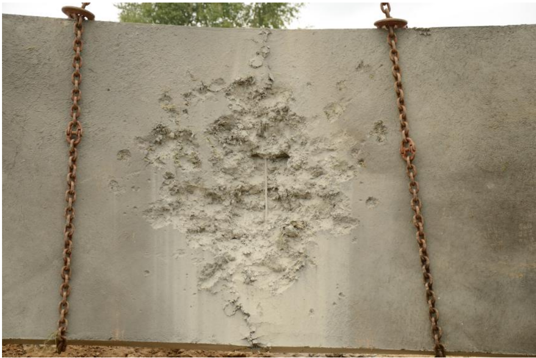
Obr. 15 – Vzorek č. 5 poškozený výbuchem – horní povrch
