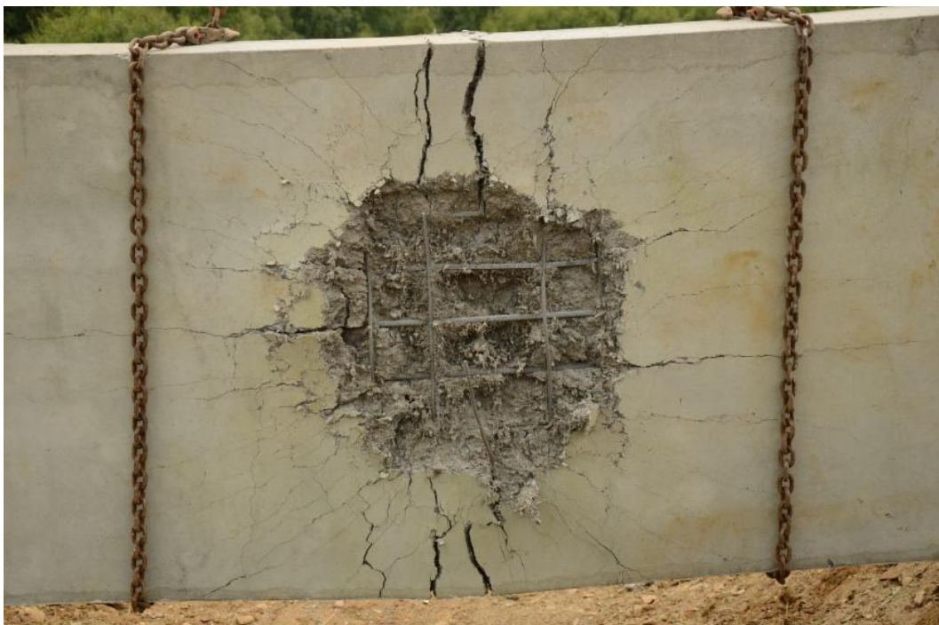
Obr. 16 – Vzorek č. 5 poškozený výbuchem – dolní povrch
