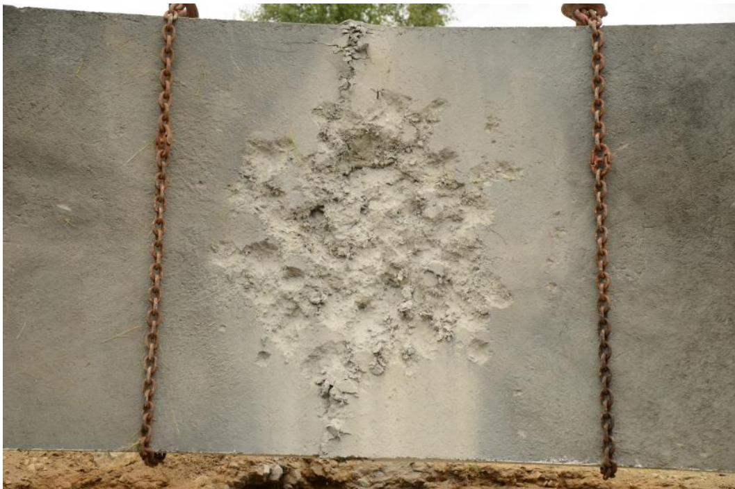
Obr. 13 – Vzorek č. 4 poškozený výbuchem – horní povrch
