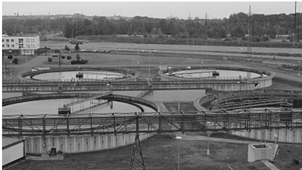
Obrázek 4 Dorrovy usazovávky v čistírně odpadních vod v Ostravě (průměr usazovávku 40m).
