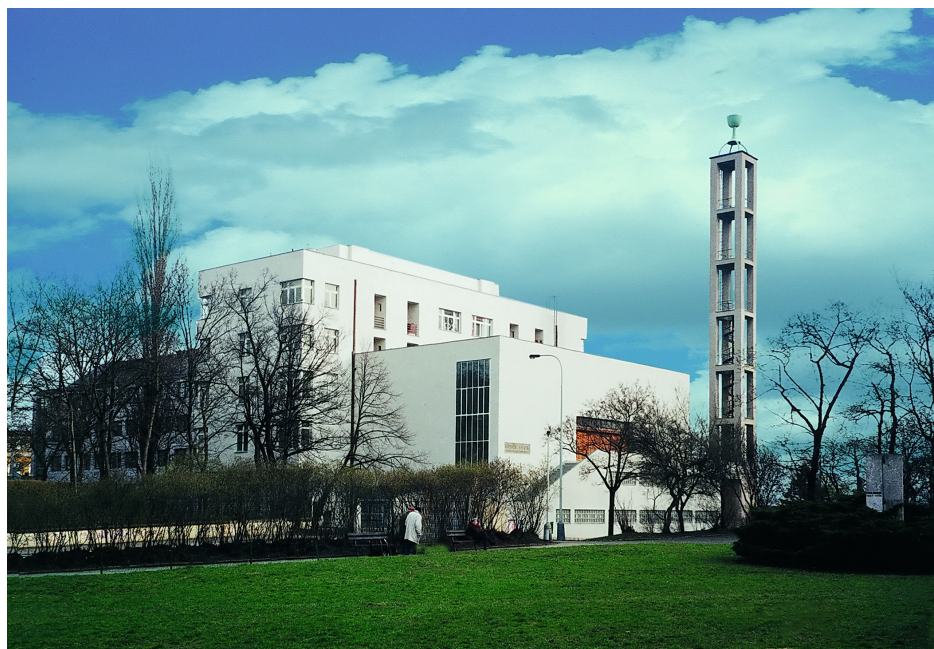
Husův sbor po 3. etapě oprav (2005)
