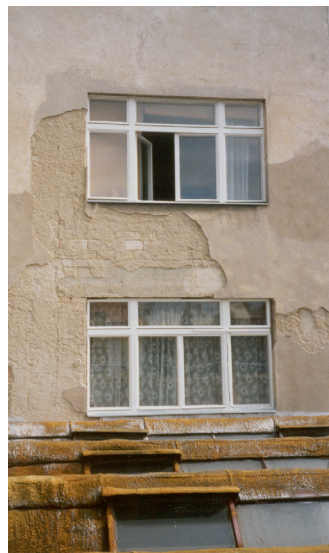
Stav objektu před rekonstrukcí
