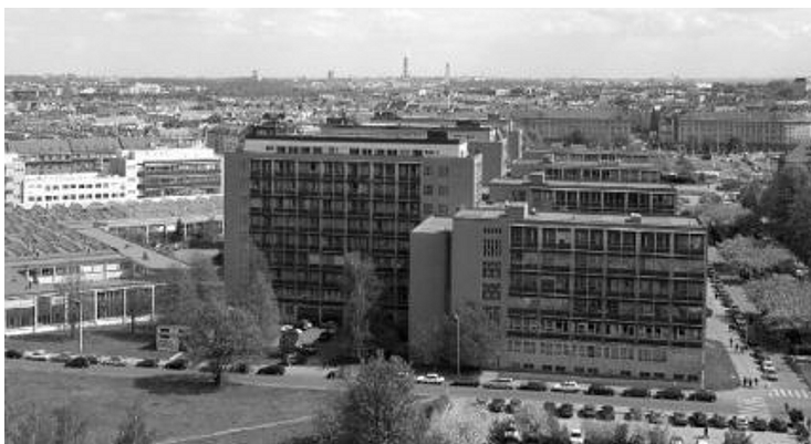
Obrázek 1: Budova ČVUT v Praze – Dejvicích, jejíž vytápění řídí od února 2010 MPC regulátor.
