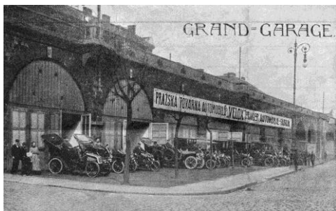
Garáže Velox v obloucích Negrelliho viaduktu
