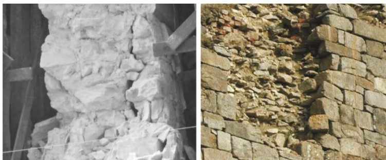
Obr. 1 Příklady vícevrstvého zdiva
