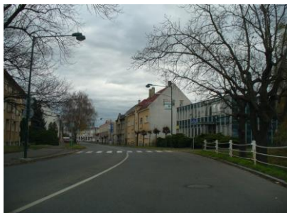
Obr. 2.4 Celkový pohled do ulice Poděbradské v Nymburce na průtahu II/330. Široký silniční průtah intravilánem představuje liniový problém (podle tab. 1.1 – červené řešení).
