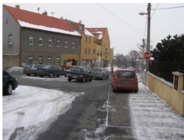
Obr. 1.12 Křižovatka v Horoměřicích funguje jako parkoviště. Sněh ukazuje skutečnou využitou plochu. Značka „stůj, dej přednost v jízdě“ je v přímém směru nesmyslně dvakrát a chodník je naznačen dlouhou zebrou (vpravo u zdi).
