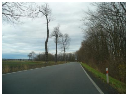
Obr. 2.5 Jedno z nebezpečných míst liniově problematického úseku nedaleko obce Netřebice. V tomto konkrétním případě by bylo nutné zvýraznit stromy nátěrem nebo ochránit zeleň svodidly (podle tab. 1.1 – žluté řešení).
