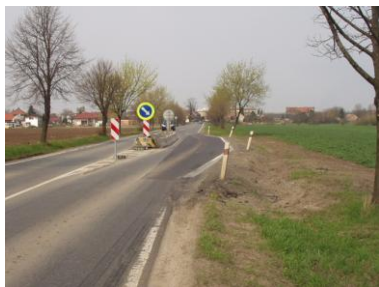
Obr. 1.11 Špatný příklad řešení vjezdové brány na silnici II/240 na začátku obce Tursko. Klasická zástavba je od tohoto místa vzdálena 400 m. Vlivem vysoké nehodovosti musel být v roce 2010 ostrůvek zrušen (foto: Ing. L. Chorváthová)
