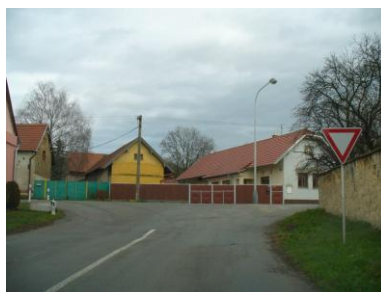
Obr. 2.7 Pohled na křižovatku II/330 a III/33018 v obci Činěves. Problémem jsou zde rozlehlé šířky jízdních pruhů na hlavní a špatné rozhledové poměry zejména z vedlejší (podle tab. 1.1 – červené řešení).
