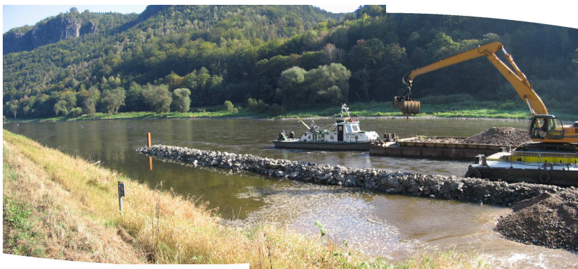
Obr. 5 Realizace výhonů v pilotním úseku dolního Labe.
