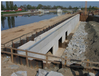
Obr. 13 Realizace dělící zdi horní rejdy (duben 2010).
