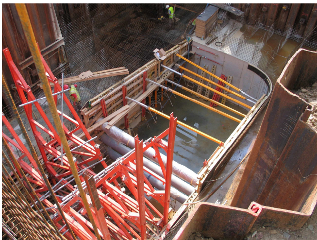
Obr. 8 Realizace tlumící komory v lokalitě (2010).
