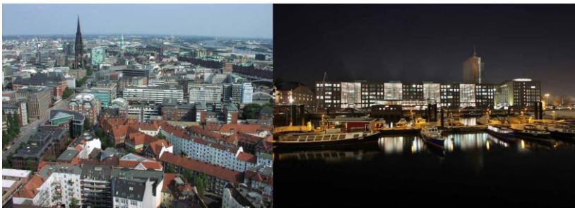
obr.2 Hamburg - příklad nízké – horizontální výstavby kancelářských budov
