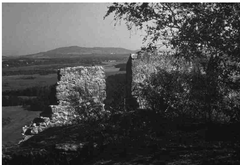
Obr. 24: Hrad Jestřebí, horní plató chrání parapetní zeď se stínkami (foto F. Gabriel).
