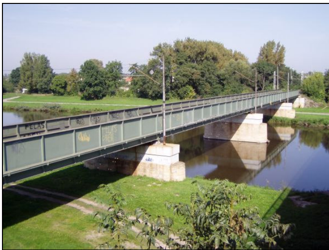
Obr.3 Plnostěnný ocelový most přes Labe
