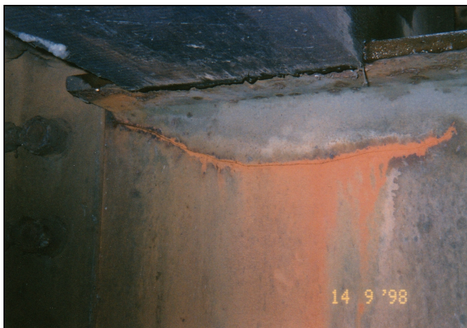
Obr.5 Únavová trhлина na podélníku
