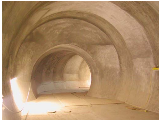
Obr.6 Definitivní ostění ze stříkaného betonu zhotovené metodou LaserShell™
