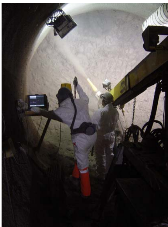
Obr. 4 Inženýr používající TunnelBeamer™ pro navádění operátora trysky
