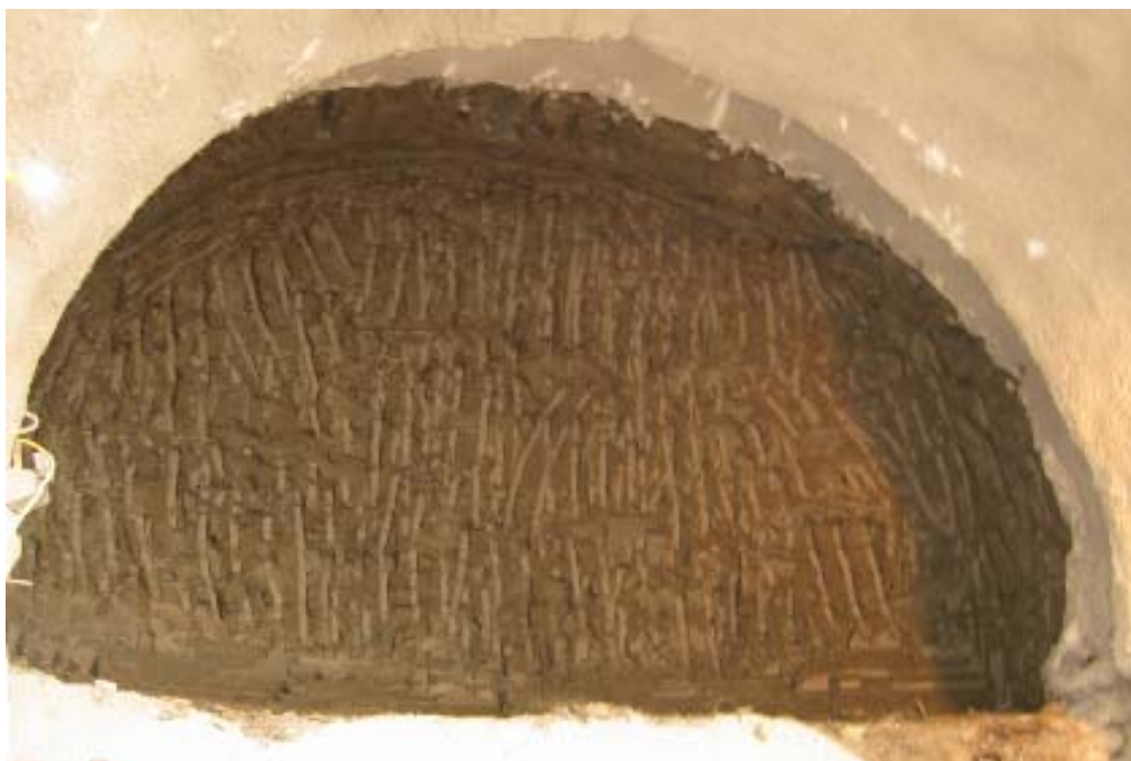
Obr.1 Čelba tunelu v prostředí londýnského jílu
