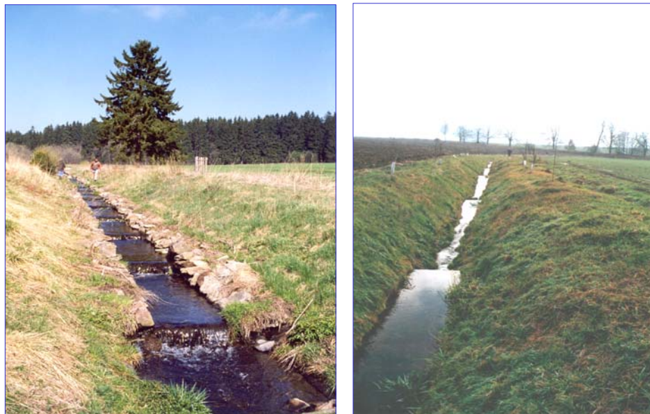
Obr 2 – Revitalizace toku vkládáním spádových objektů (foto autor)
