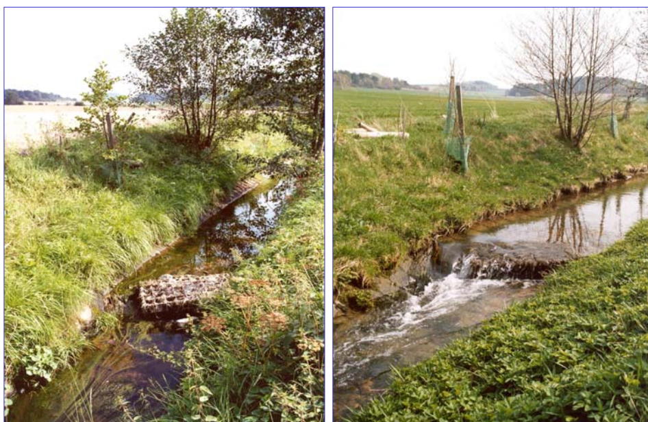
Obr 3 – Využití gabionu jako vloženého revitalizačního prvku – funkce při různých průtocích (foto autor)
