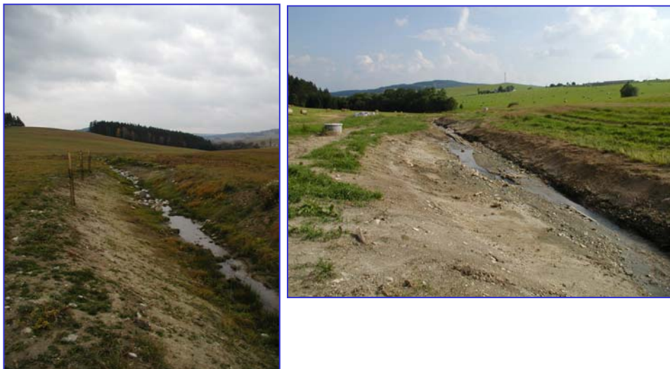
Obr 5 – Střídavé stržení břehů koryta při ponechání opevnění dna polovegetačními tvárnicemi (foto autor)
