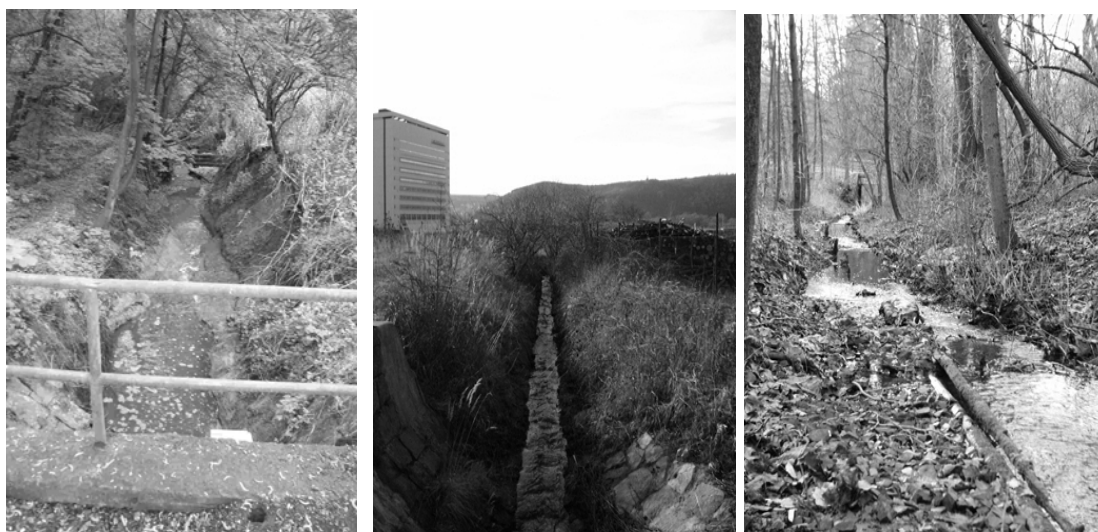
Obr. 3: Stav Zátišského potoka (a-zvýšená eroze koryta, b-umělé koryto, c- zbytky revitalizačních opatření ze 70.let 20.století)
