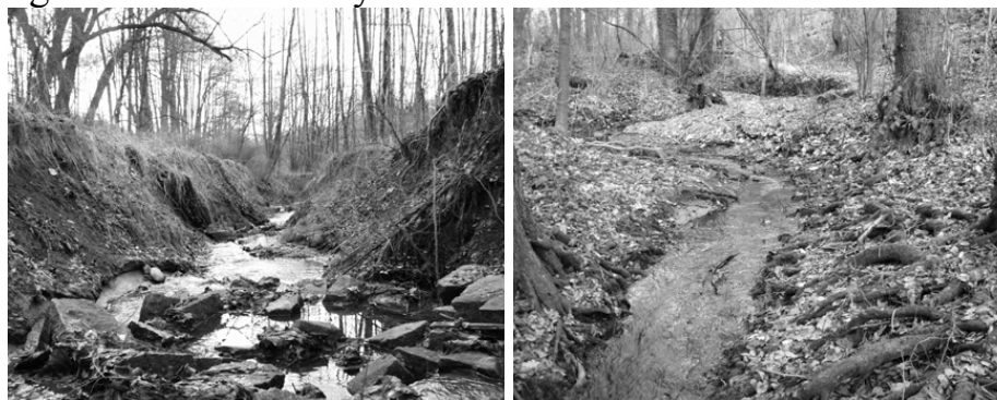
Obr. 4: Zátíšský potok (a-zvýšená eroze koryta a zničené opevnění břehů, b- přirozená část toku)
