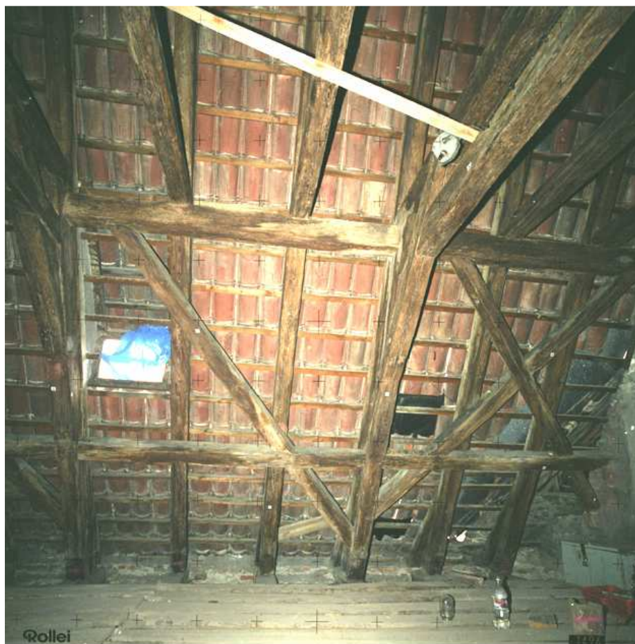
Obr.24 : Digitální snímek krovu a fotogrammetrické vyhodnocení
