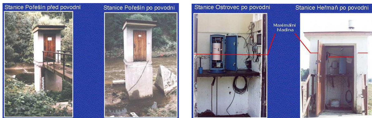
Obr.1. – Poškozené a zatopené limnigrafické stanice ČHMÚ v průběhu povodně v srpnu 2002
