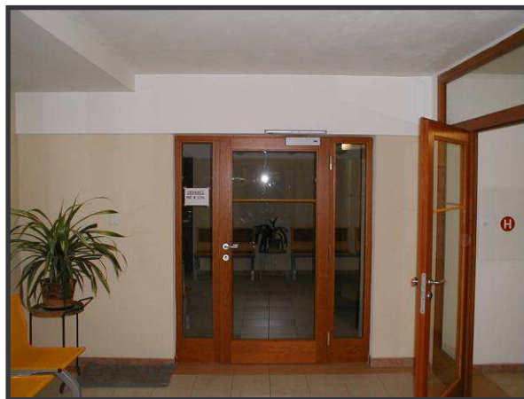
Obr. 20 a 21 Zobrazuje konečné řešení prostoru po provedení nových otvorů v dělicích nosných stěnách.
