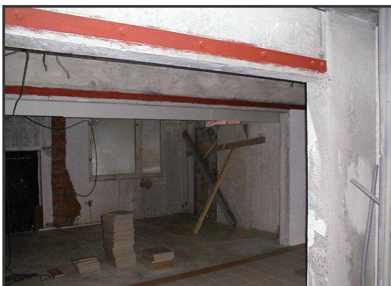
Obr. 19 Pohled na instalovanou plochou ocel ukotvenou chemickými kotvami a opatřenou základním nátěrem, následně bylo provedeno její zakrytí sádkartonovým protipožárním obkladem.
