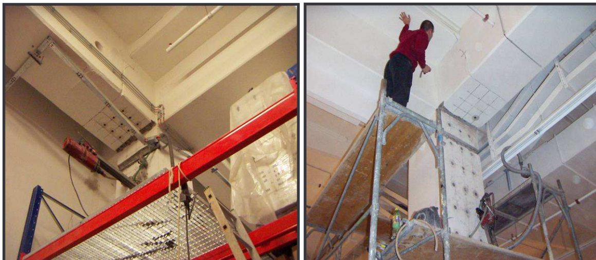
Obr. 27 a 28 Ukazují postup provádění krátké konzoly, kdy bylo nutno rozměřit a následně vyvrtat do 18 otvorů pro kotevní šrouby a následně pomocí vysokozdvizného vozíku osadit ocelový krakorec o hmotnosti cca 1,4 tun.
