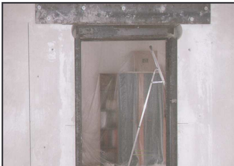
Obr. 15 Pohled na zesílení nadpraží pomocí vloženého ocelového rámu.
