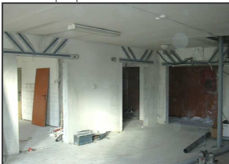
Obr. 16 Pohled na vyříznutý otvor v příčné nosné stěně se zesíleným nadpražím pomocí FRP výztuže, která je modernější alternativou pro plochou ocel, kterou je nutno mechanicky kotvit.
