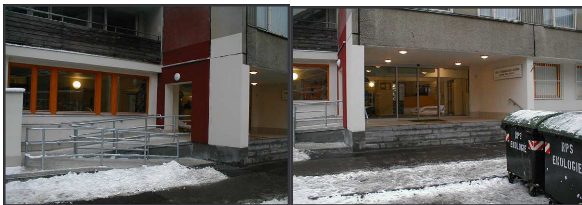
Obr. 16 a 17 Zobrazují pohled na nově provedený bezbariérový vstup do objektu, tj. rampu pro vozíčkáře zapuštěný vstup, zde odstraněn celý fasádní panel.
