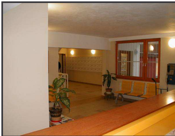
Obr. 20 a 21 Zobrazuje konečné řešení prostoru po provedení nových otvorů v dělicích nosných stěnách.
