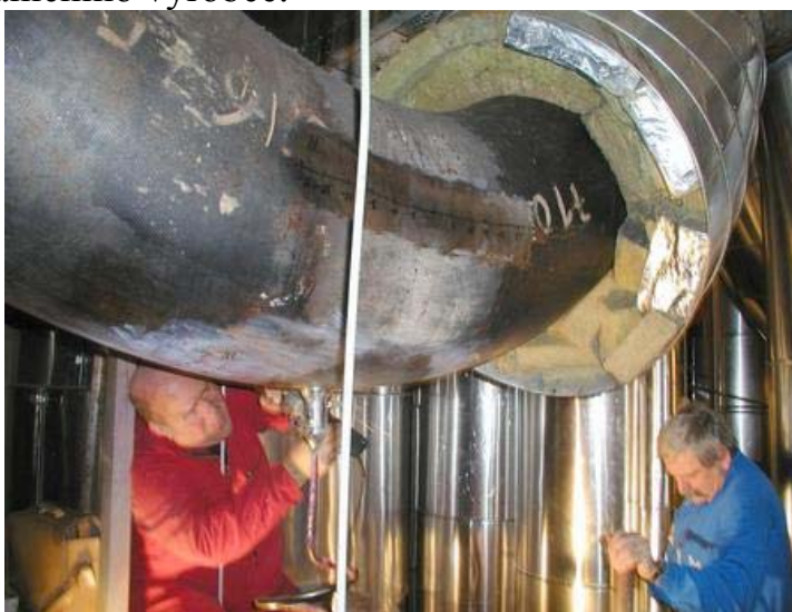
Obr.17. Pohled na dolní část převáděcího potrubí s odvodněním
