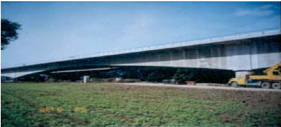
Fig. 6 View of bridge over Labe river at Mělník
